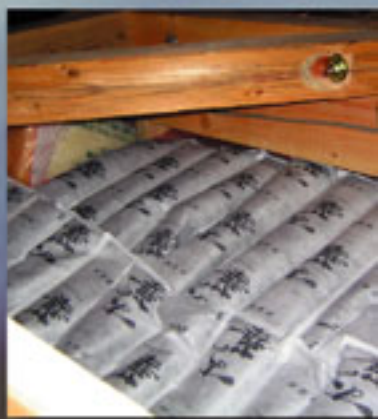
住宅天井裏への施工
