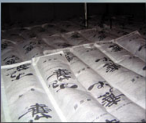
住宅床下への施工
